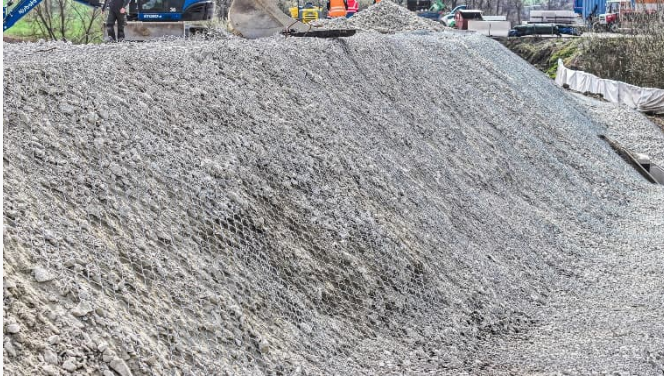
Abbildung 3: Einbau des Biberschutzgitters und der Amphibienleiteinrichtungen im Teilabschnitt „B“
