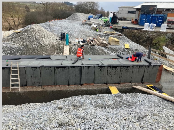
Abbildung 4: Abdichtungsarbeiten beim Setzgraben
