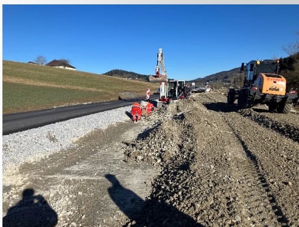
Abbildung 2: Herstellung der Bodenauswechslung und des Frostkoffers
