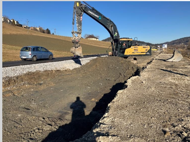
Abbildung 1: Abtrag des alten Straßenoberbaues im Teilabschnitt „B“
