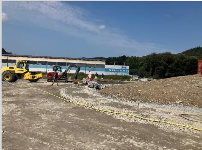
Abbildung 1: Herstellung aller Pflasterungen und Randbegrenzungen im Teilabschnitt „A“
