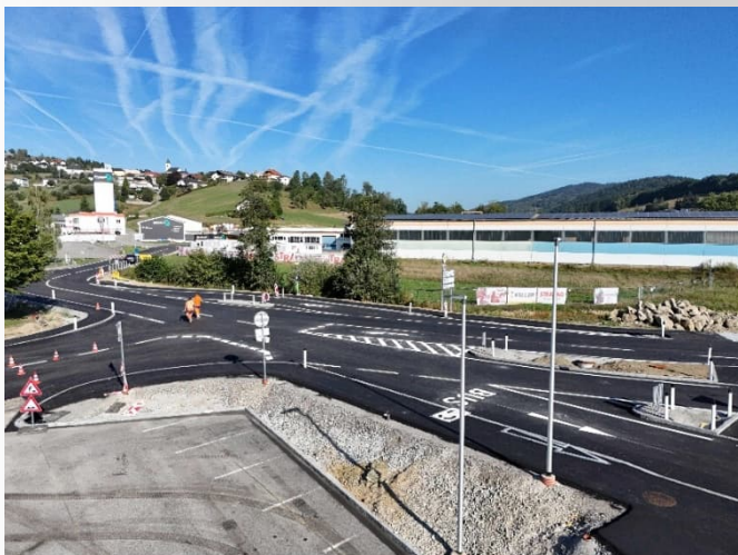
Abbildung 5: Abschluss der Markierungsarbeiten
