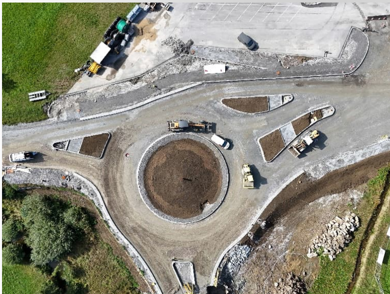
Abbildung 2: Fertigstellung der ungebundenen Tragschichten
