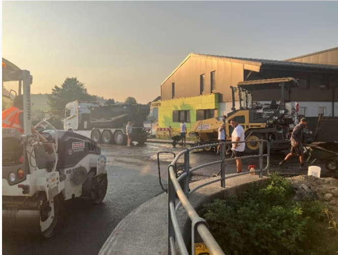
Abbildung 3: Finalisierung der Asphaltierungsarbeiten im Teilabschnitt „A“
