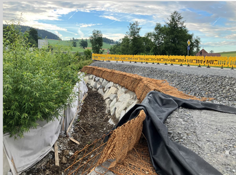
Abbildung 4: Herstellung der bewehrten Erde inklusive Steinsatz
