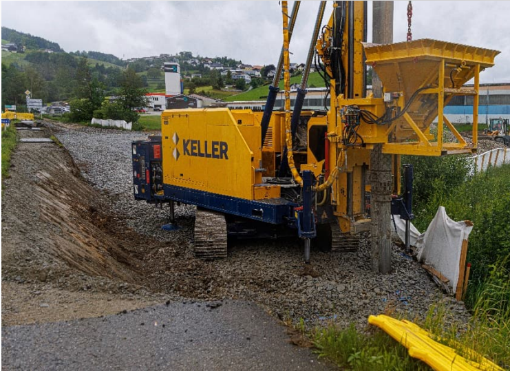
Abbildung 3: Abschluss der Bodenverbesserungen im Bereich des Pendlerparkplatzes
