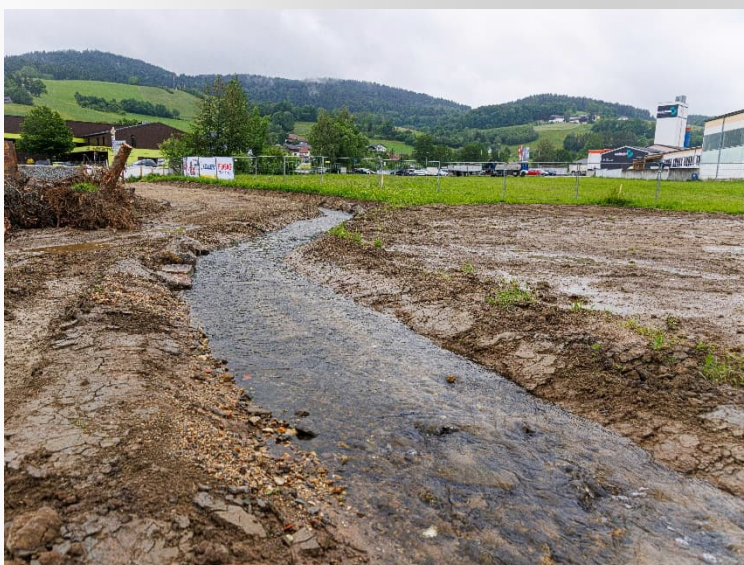
Abbildung 2: Provisorische Umlegung des Wäschbachls
