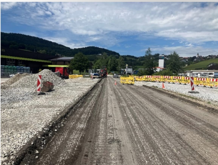
Abbildung 5: Abtrag der bituminösen Schichten im ersten Bereich der B38 Böhmerwaldstraße
